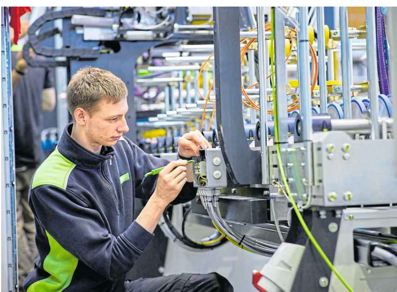
Elektroniker Lukas Furchert verdrahtet eine Profilmantelungsanlage.
